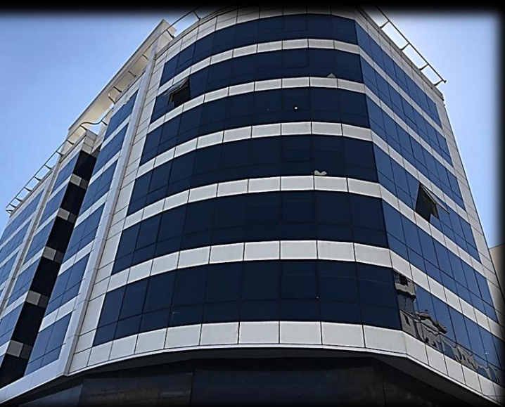
دفتر مرکزی شرکت عمرانی مسکن گستر نمای کامپوزیت و اچ پی ال فاندراکس اتریش
